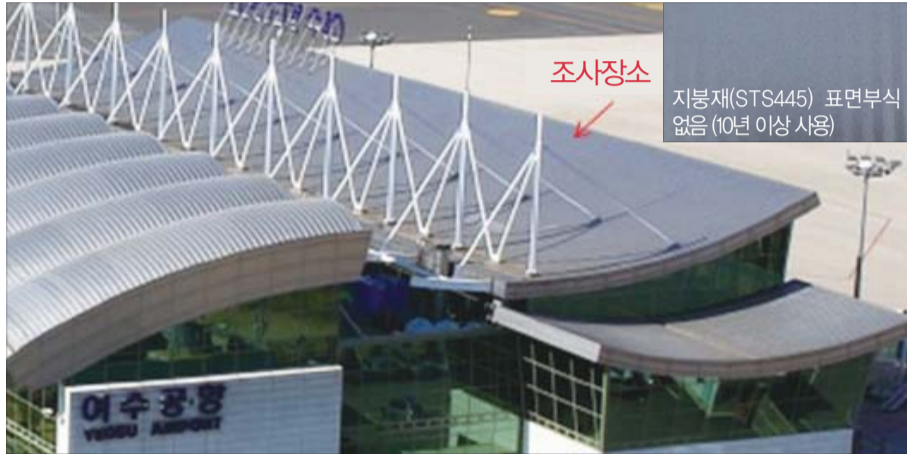
스테인리스 지붕재로 건설된 여수공항 여객터미널 (2005년 준공)
